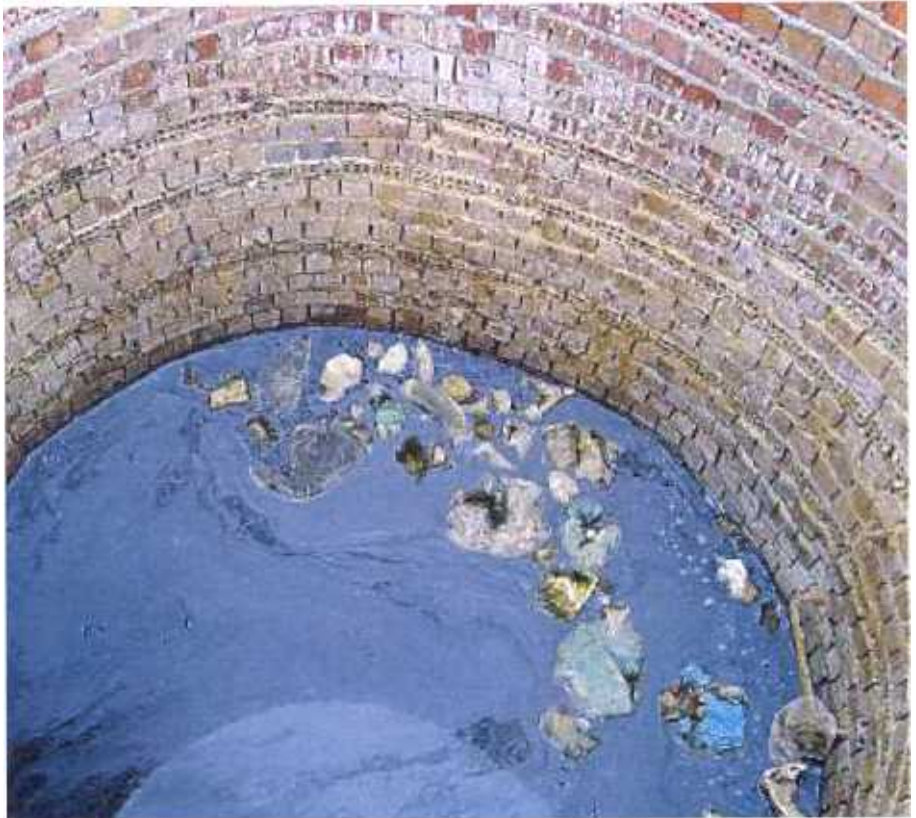
Vista del pozo de recogida de lixiviados.
