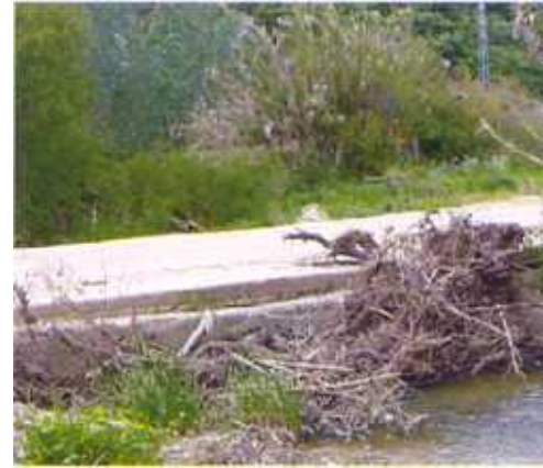
La obra de paso que se pretende sustituir.
